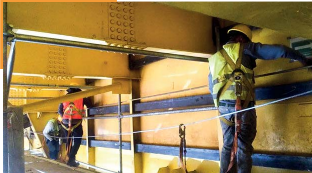
Proceso de instalación de acero de refuerzo
