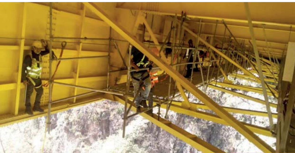
Instalación de pasarelas de andamios
