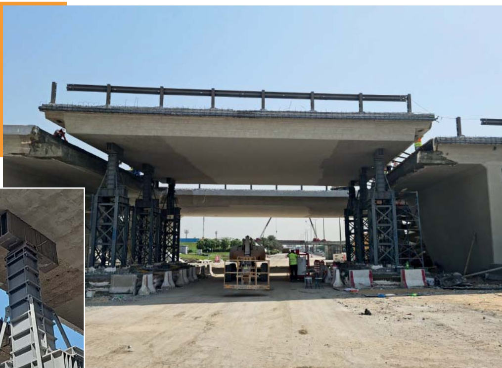
Vista general del sistema una vez completado el izado
