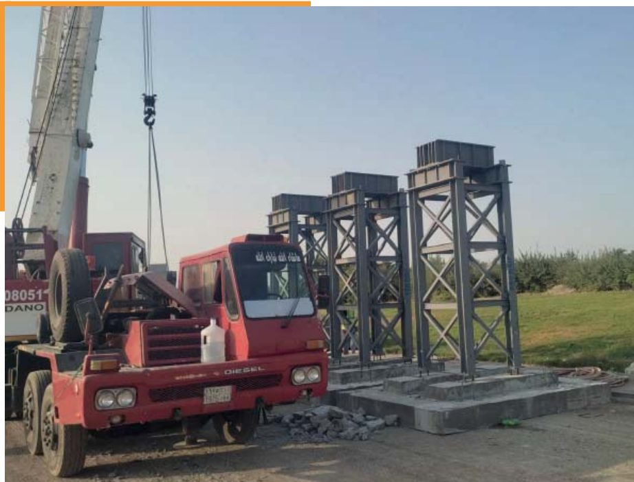
Instalación de las zapatas y las torres
